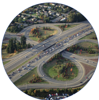
Surveillance du Bruit de Trafic Routier
